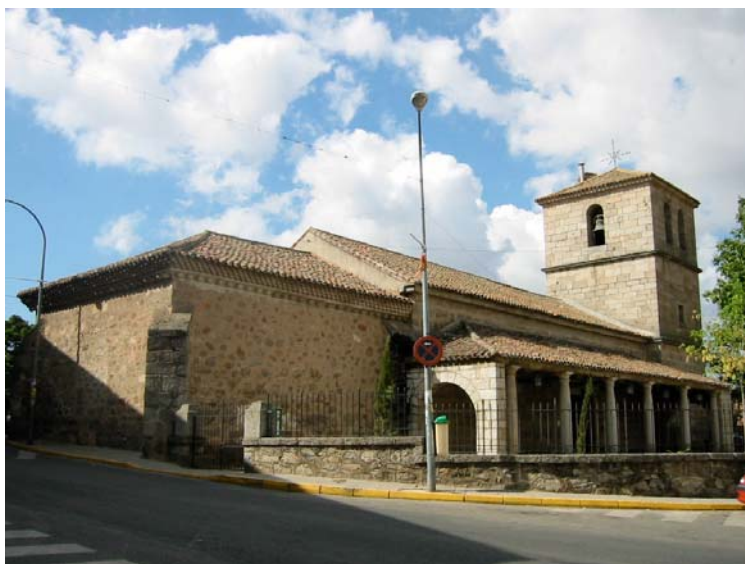
Fachada principal de la iglesia
