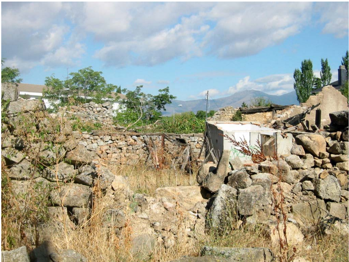
Área en ruinas en la zona norte (PO PE-4)
