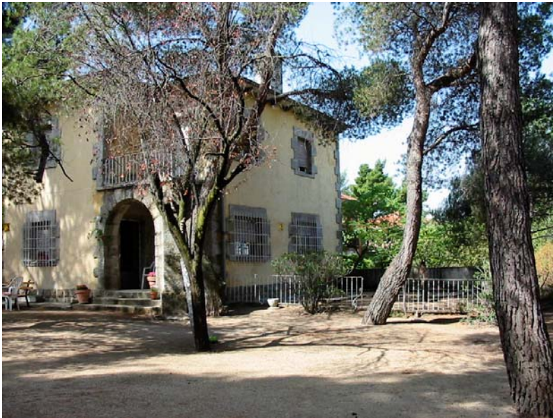
Chalé de veraneo con esquinas arco y jambas de piedra en estilo serrano
