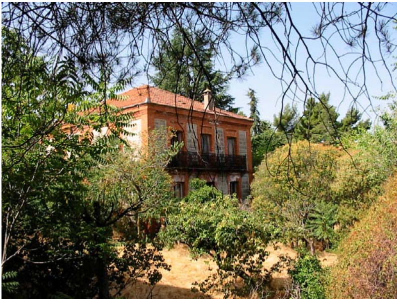
Chalé de veraneo con esquinas recercados y alero de ladrillo con muros de mampostería de piedra
