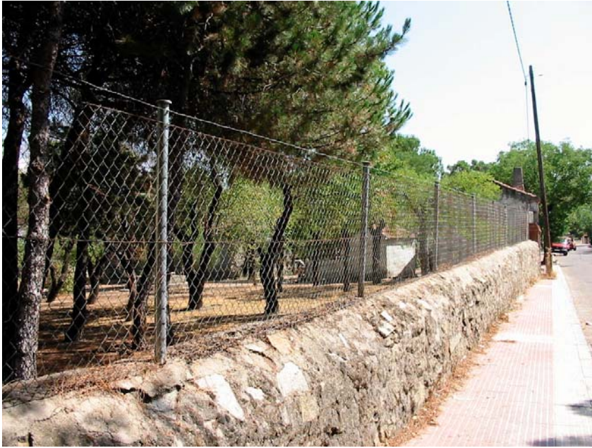
Cerramiento alterado con malla metálica visible
