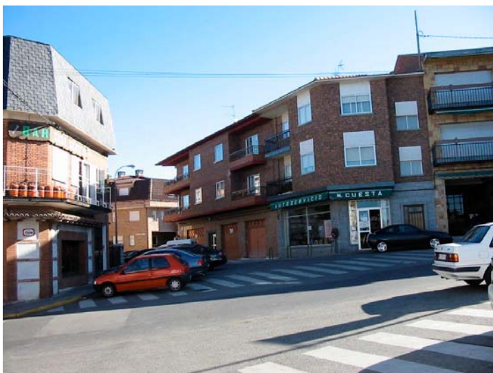
Edificación de los años ochenta
