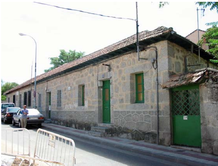
Edificación tradicional de una planta
