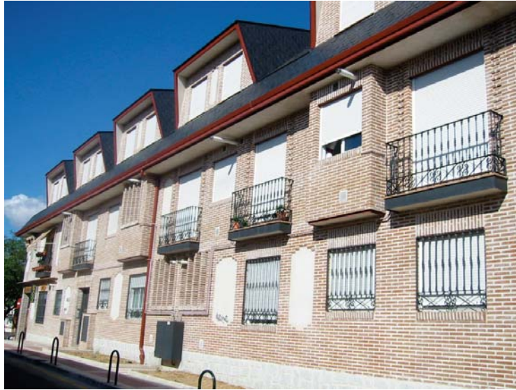
Edificación de los años noventa
