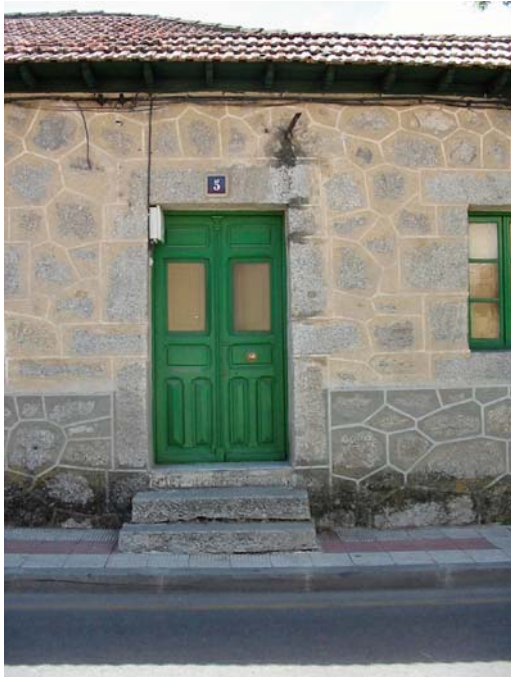
Puerta con sillares de piedra
