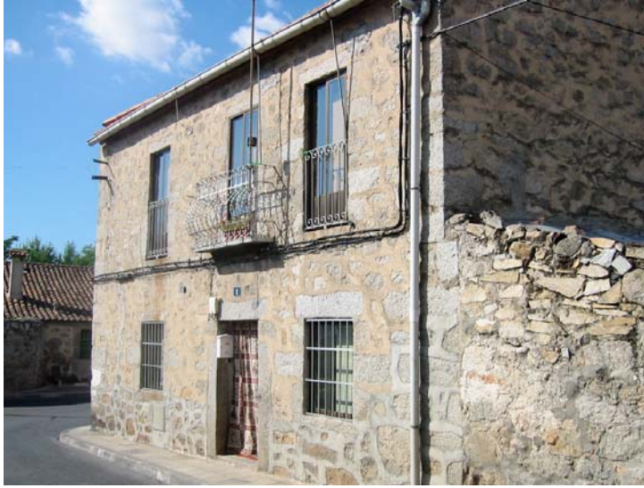
Edificación tradicional de dos plantas
